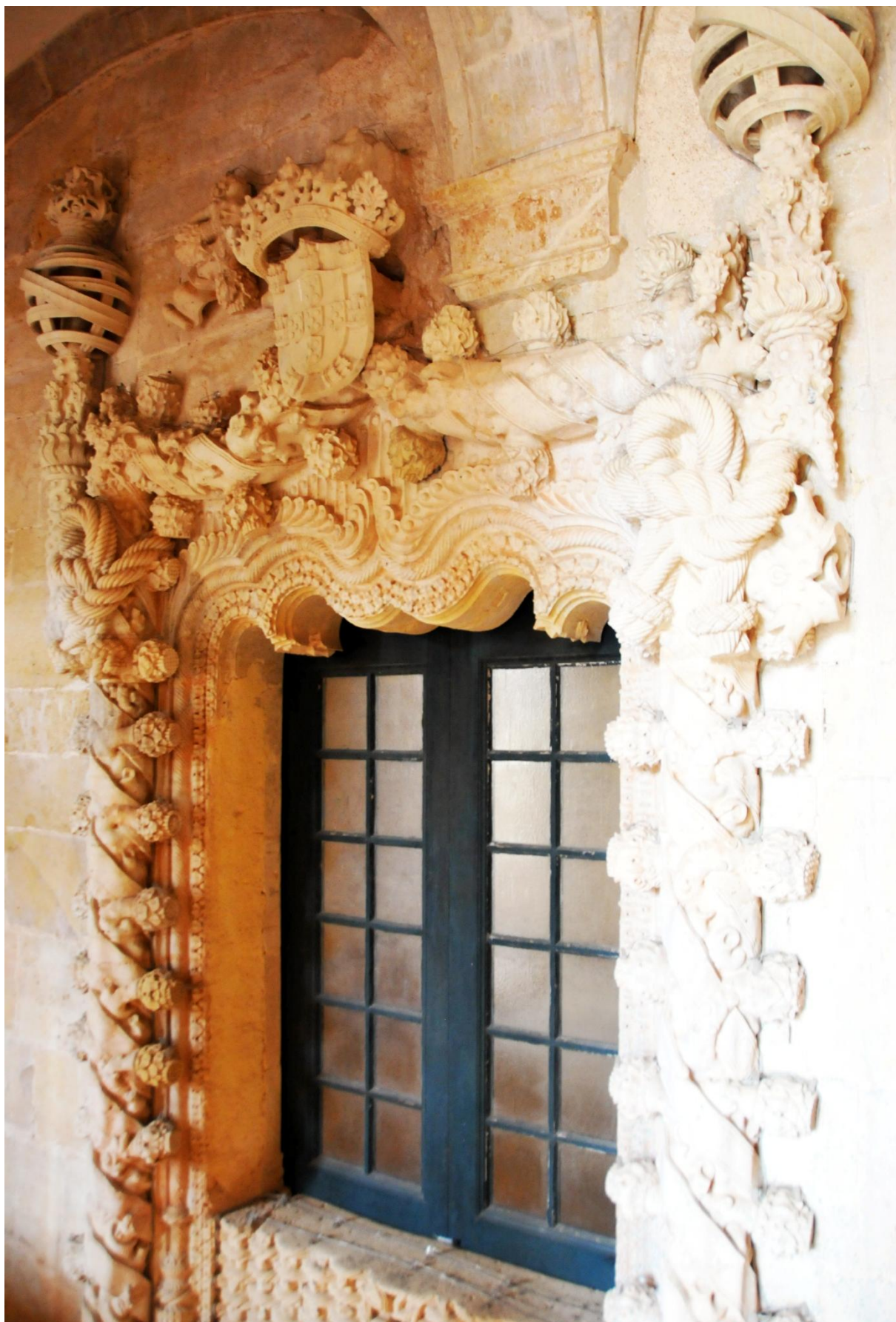
Dette er et typisk manuelinsk vindu - helt uskadet av lav og vekster.
